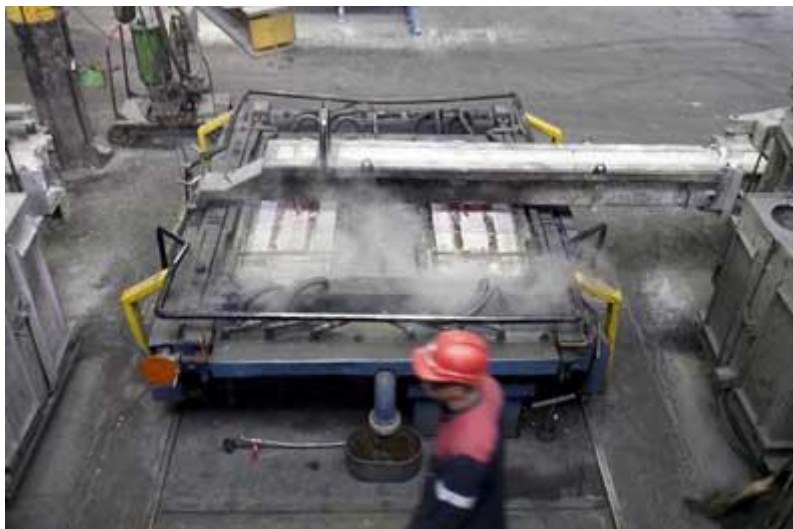
Intensiver Stromverbrauch: Die Stranggiessanlage.
